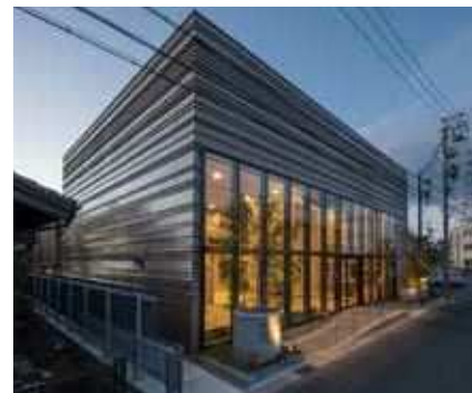
働き幅を変えた鋼板張りの内外壁は地層を連想させる
