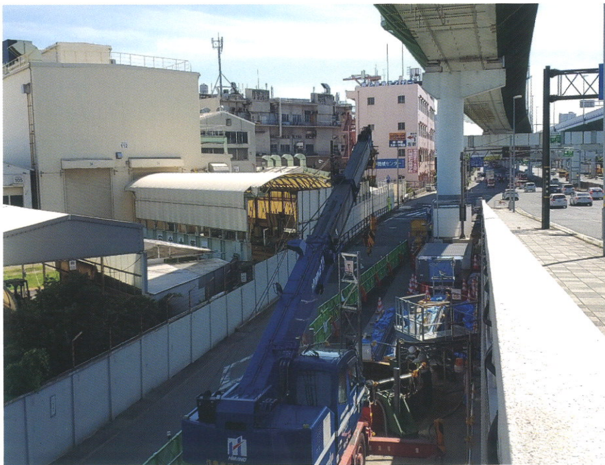
アーバンファンデーション工法の 施工機械全景
