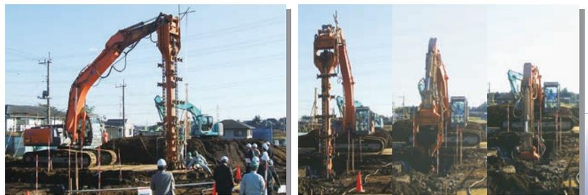
施工時の機械高さの測定状況
